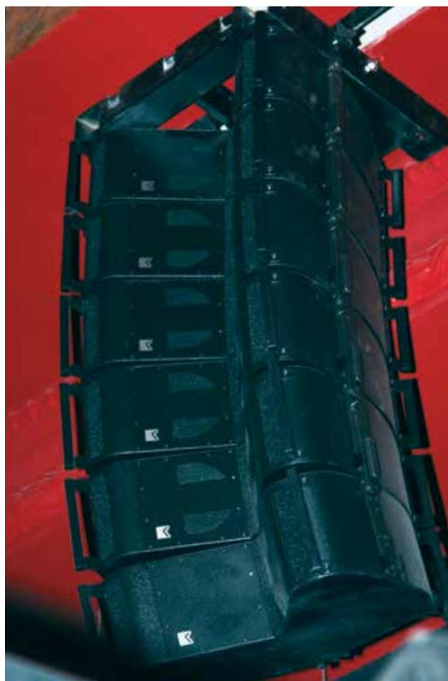
необходимое дополнительное оборудование решено было сделать выносным и подключать его в зависимости от потребностей. Тем не менее, некоторый базовый комплект такого оборудования установили стационарно, например, 4 подвесных прострела сцены, построенные на 15-дюймовых коаксиальных акустических системах с 3-дюймовыми драйверами.
