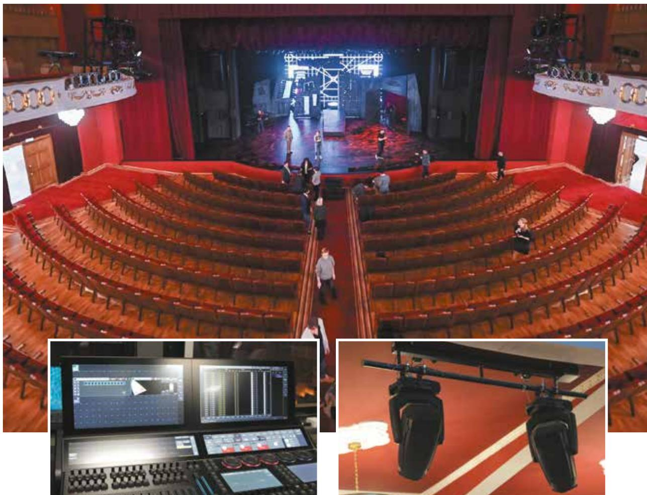
Командой проектировщиков была принята концепция, что основой сценического освещения станут приборы динамического света, управляемые с пульта, чтобы максимально исключить «человеческий фактор». В театре установили бесшумные светодиодные приборы нового поколения, обеспечивающие плавный переход и затухание света, отвечающие театральным требованиям.
